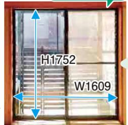
客間として使用し、普段はあまり使っていない和室。築25年、もともと障子窓の部屋だったが障子紙は破れてポロポロ。そして北側の部屋のため冬はかなり寒い。部屋の寒さの原因は、ほとんど窓にあるらしい。補助金制度があるうちに、と思い切って内窓リフォームをすることにした。事前の現場調査で採寸。ガラスの種類や窓枠の色を指定して見積りをもらう。目隠し効果も期待し「和紙調ガラス」を選択、フレームは柱の色目に合わせた「ナチュラル」に決定。
