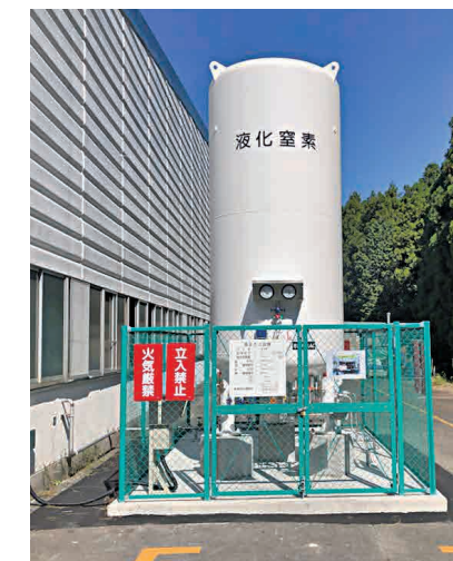
窒素供給先へのCE設備設置
